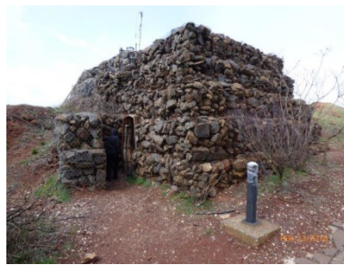
Israeli bunker at Har Ben Tal
